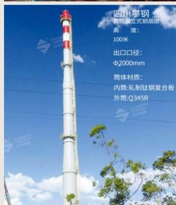
随着国内石油炼化行业的兴起，针对炼化厂的建设，新型钢制烟囱已经替代传统混凝土烟囱成为主流，钢制烟囱不仅造价更优惠，制作工期更短，占地面积更小，外形更加美观，而且降低了眼的投资成本，且在基础、布局、占地空间、运行时间更加为客户节省费用。
